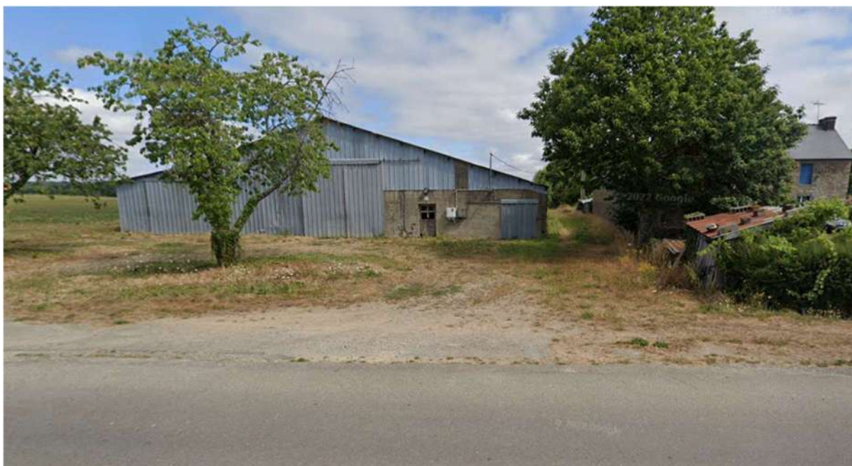
Vue du site depuis la route communale de la Gréonais au sud.
